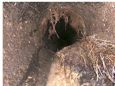
Wurzeleinwuchs an undichter Rohrverbindung
