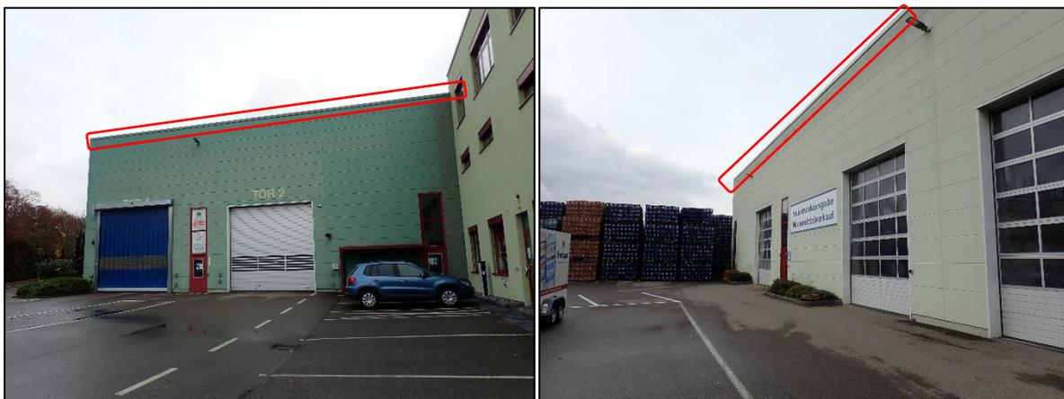
Abbildung 5: Attika (rote Markierung) am gesamten Dachbereich des Logistikgebäudes.
