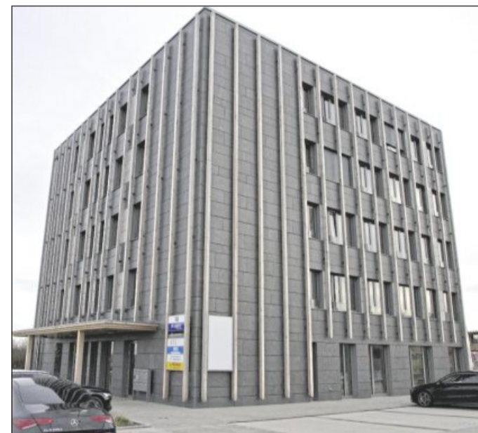
Wie energieeffizientes Bauen heute gelingt, zeigt ein modernes Bürogebäude im Industriegebiet Sachsenheim. Grafik/Fotos: Randoll
