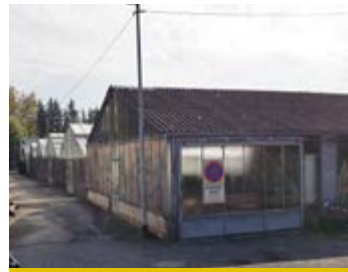
Leerstand der Gewächshäuser am Weller-Areal
