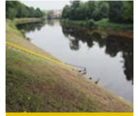
Enzufer steil und verbaut
