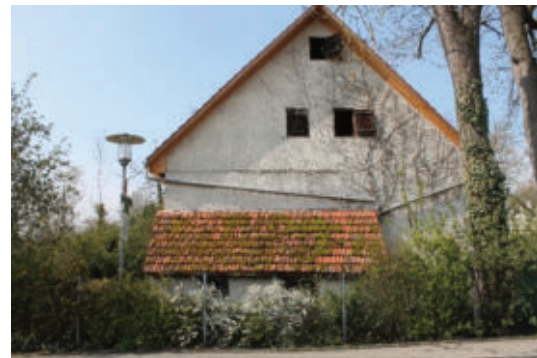
Abbildung 6: Gebäude Im Mühlkanal (Quelle: WHS, 2021)
