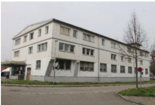
Abbildung 5: Gebäude Im Mühlkanal (Quelle: WHS, 2021)
