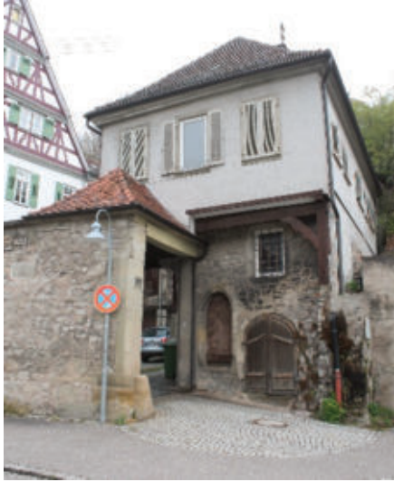
Abbildung 3: Gebäude Mühlstraße (Quelle: WHS, 2021)
