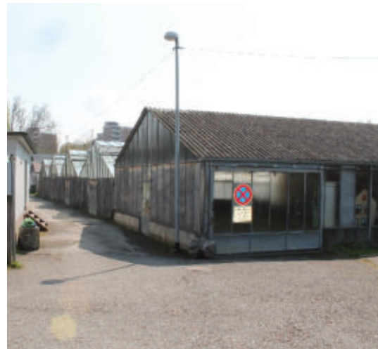
Abbildung 17: Leerstehende Gewächshäuser Walter-de-Pay Straße (Quelle: WHS, 2021)
