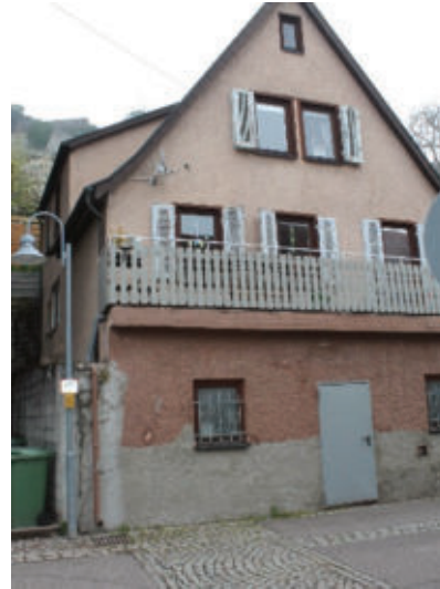
Abbildung 4: Gebäude Mühlstraße (Quelle: WHS, 2021)
