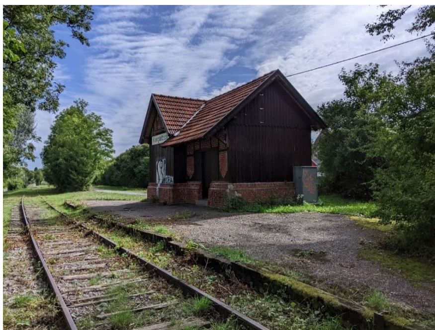
Abbildung 31 WEG-Trasse Alte Bahnstation Kleinglattbach (09/22)
