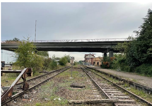
Abbildung 40 Ausbau WEG-Trasse Kleingalattbach
