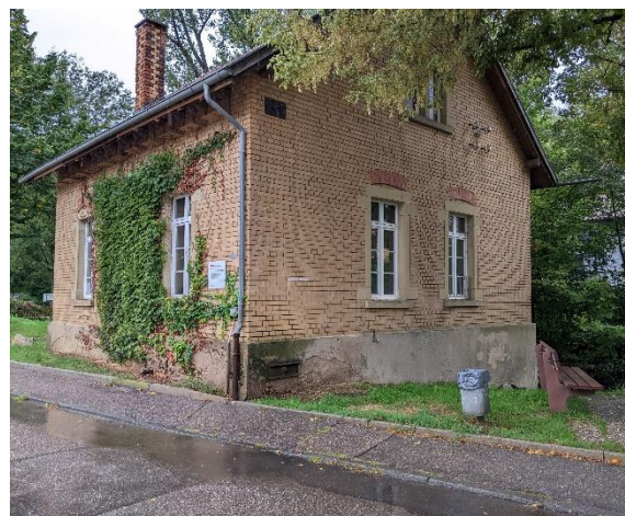
Abbildung 33 Aufwertung Pumpenhäuschen Riet und Umfeld.
