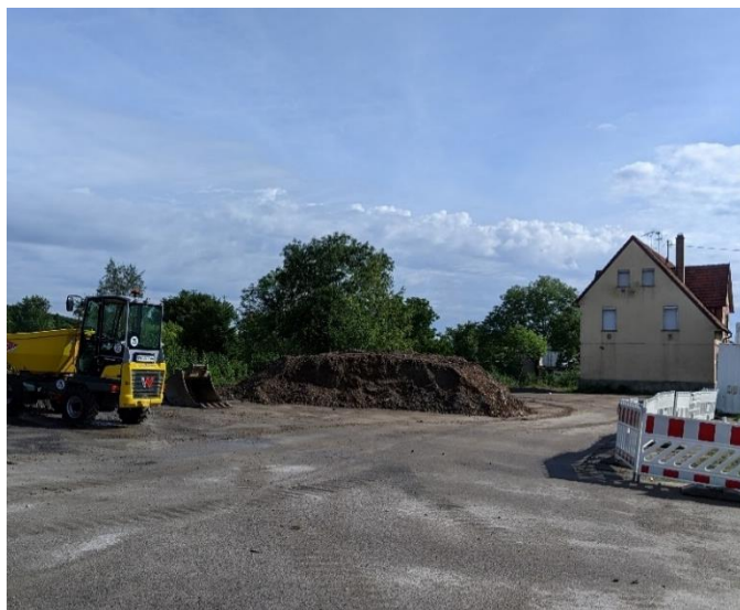
Abbildung 35 Altes Bahnhofsareal Enzweihingen/ Städtebauliche Entwicklung. Sanierung Altes Bahnhofsgebäude und Zuführung einer Nutzung.
