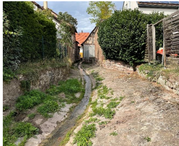
Abbildung 37 Renaturierung und Entsiegelung Gündelbach
