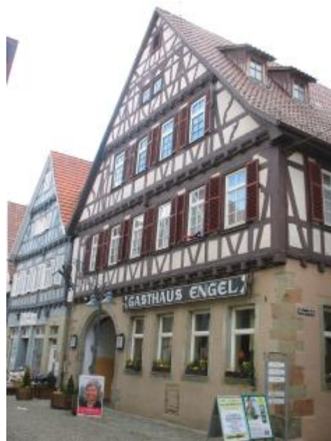
Foto 4: Stuttgarter Straße - Fachwerk
