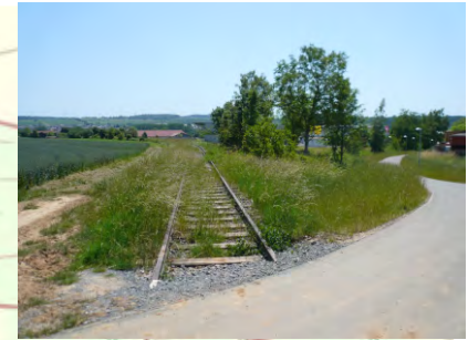
29-WEGEWECHSEL ÖSTLICHES UND WESTLICHES PARALLELSYSTEM BEREITS BESTAND
