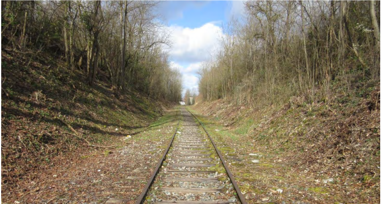
Streckenabschnitt Nr. 1.4 im Geländeeinschnitt
