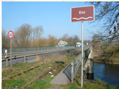
34-BRÜCKENSANIERUNG ENZBRÜCKE IM ZUGE DER B10 (RP STUTT GART REF. 43)
