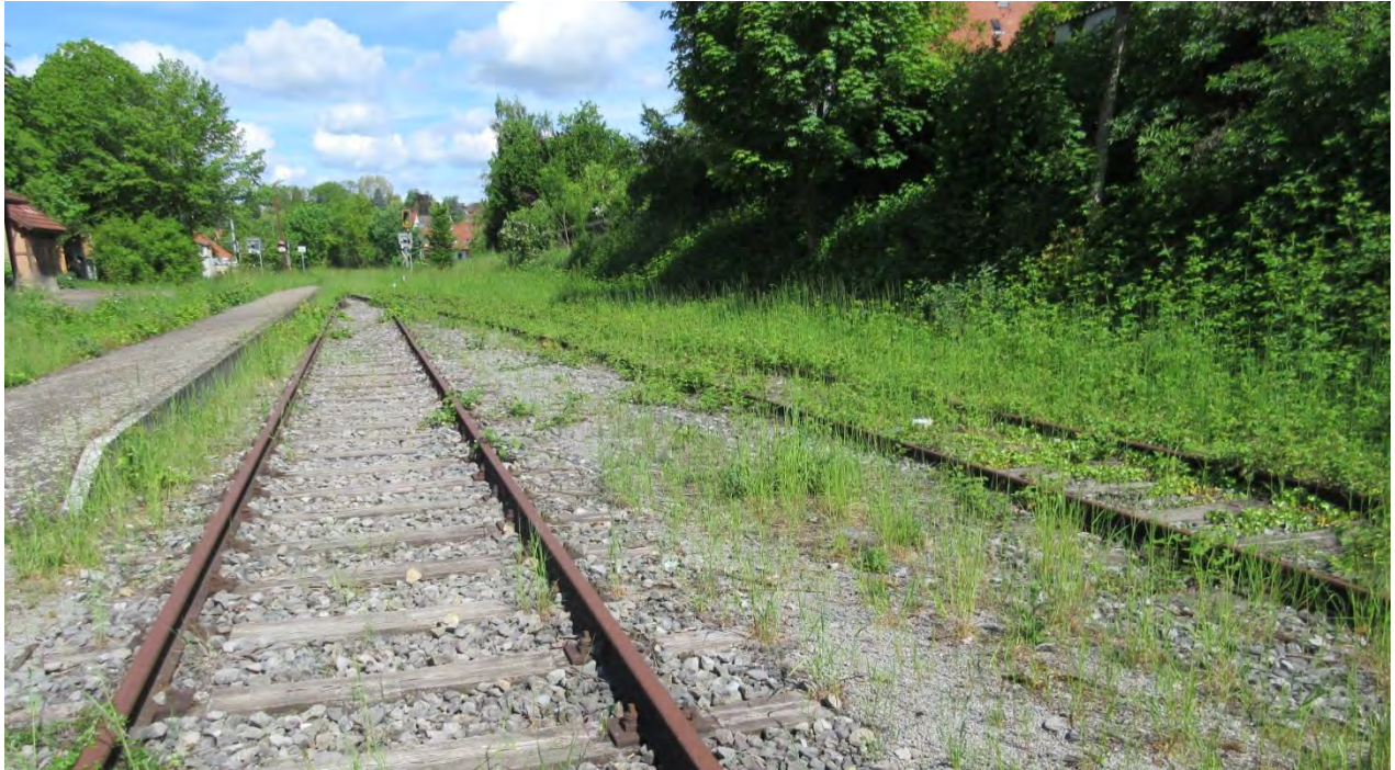
Gleisbett und Ruderalflächen im Bereich des ehemaligen Stadtbahnhofs Vaihingen
