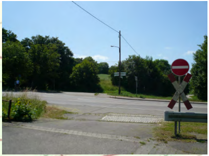
35-ANBINDUNG VAIHINGER STRASSE BEREITS BESTAND (VERSTÖSSE GEGEN VERKEHRSRECHTLICHE ANORDNUNG StVO, ZEICHEN 267, z.B. B10-QUERUNG IN RI. „BRÜCKENWASEN“ = BAULICHE UNTERBINDUNG ERFORDERLICH)
