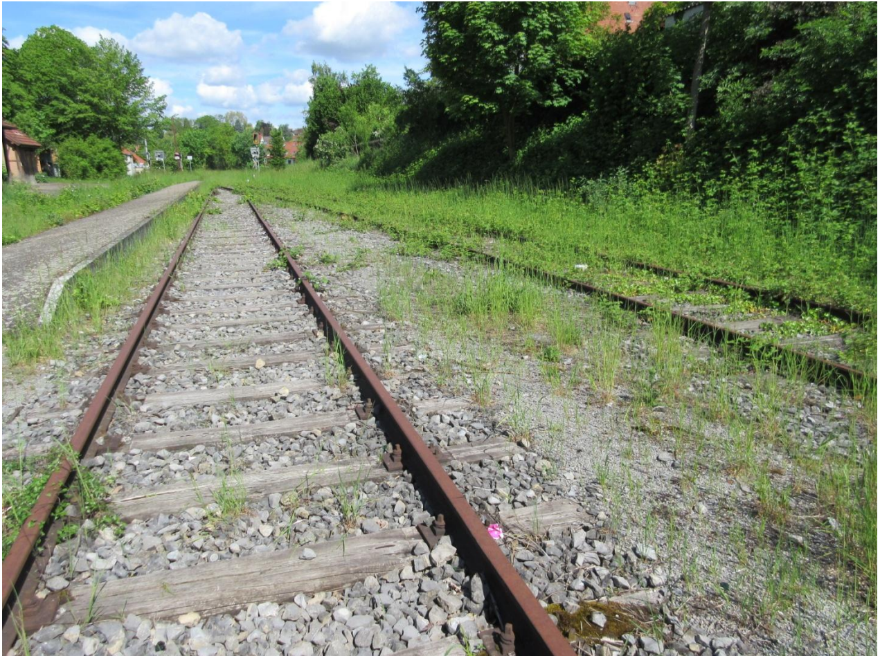
Gleisbett im Bereich des ehemaligen Stadtbahnhofs Vaihingen
