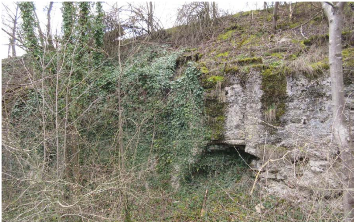
nordexponierte Felswand am ehemaligen Steinbruch
