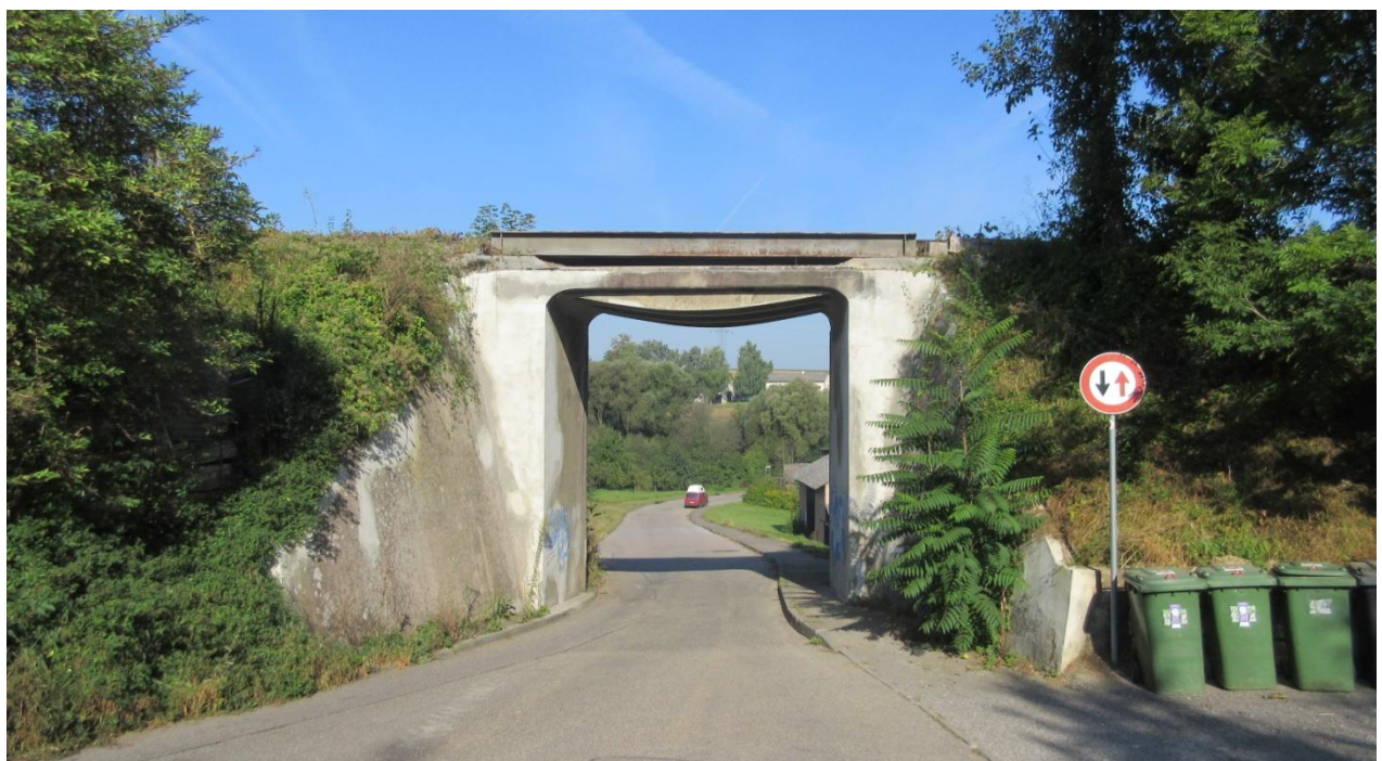
Brücke im Bereich ‚Fuchsloch‘
