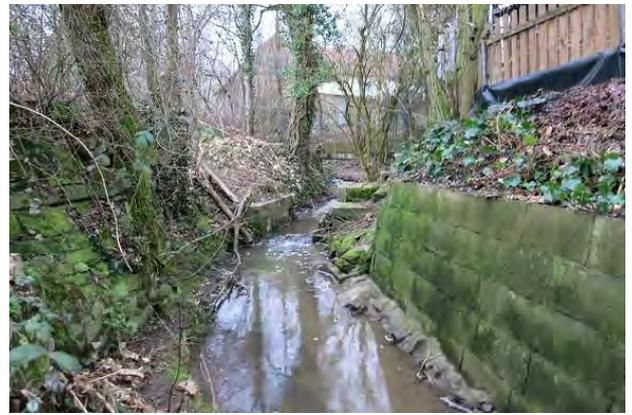
**Abbildung 29: Uferbefestigungen am Gewässer (Blick gegen Fließrichtung)**
