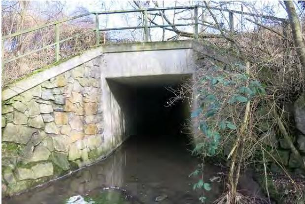
**Abbildung 21: Auslauf des Glattbachs aus der Verdolung im Bereich der Schnellbahnstrecke (Blick gegen Fließrichtung)**
