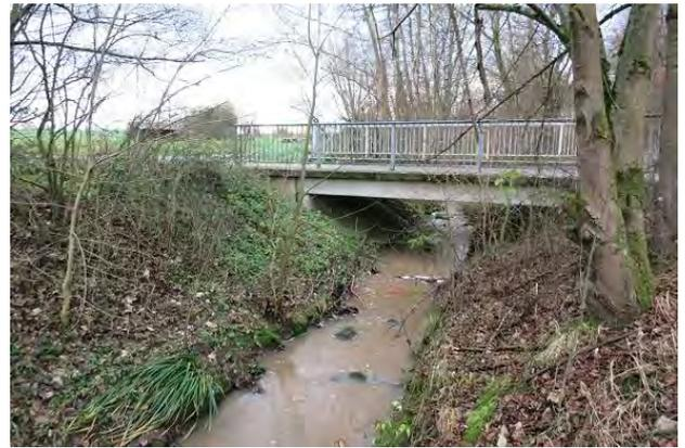
**Abbildung 35: Brücke mit durchgängiger Gewässersohle (Blick gegen Fließrichtung)**
