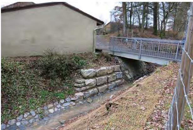
**Abbildung 51: Ufersicherungen im Bereich der Brücke (Blick gegen Fließrichtung)**
