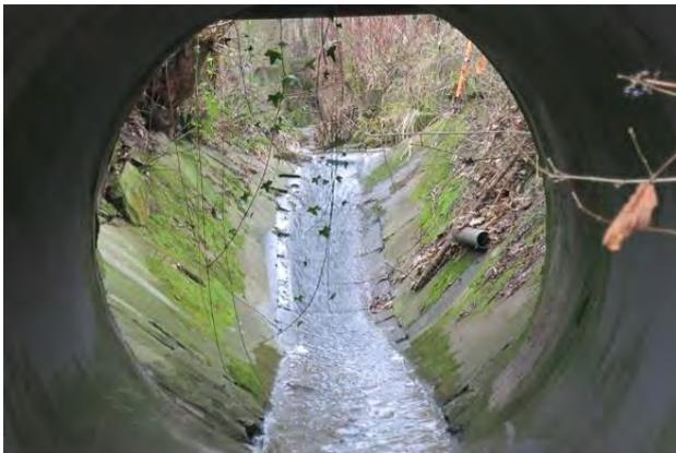
**Abbildung 28: Glatte Rampe und ein Rohrdurchlass (Blick gegen Fließrichtung)**
