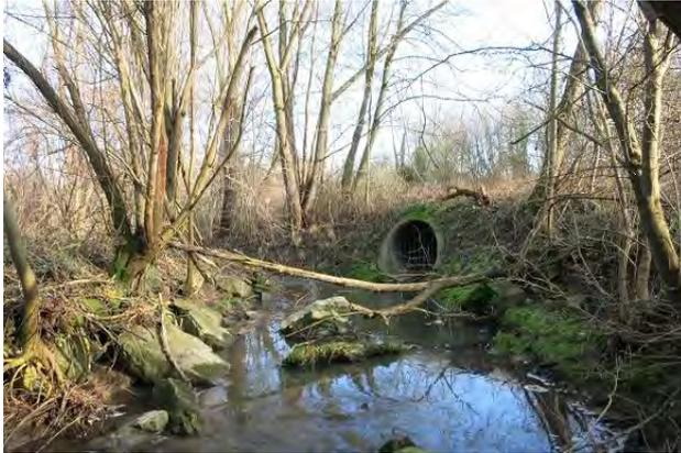
**Abbildung 17: Auslauf eines Regenüberlaufbeckens (Blick gegen Fließrichtung)**
