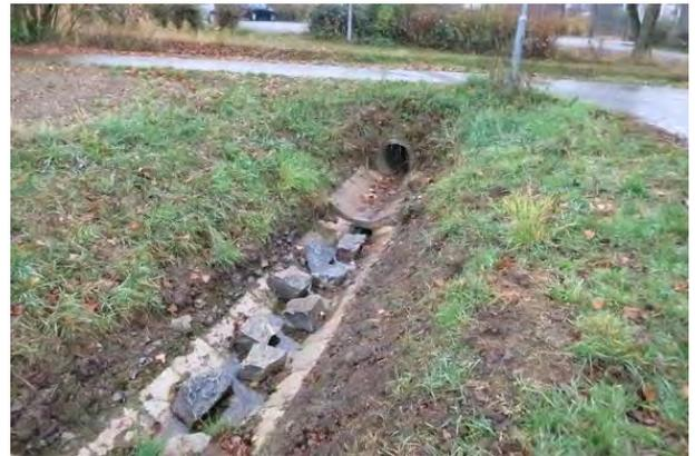
**Abbildung 60: Sohlschalen und Rohrdurchlass im Seegraben (Blick in Fließrichtung)**
