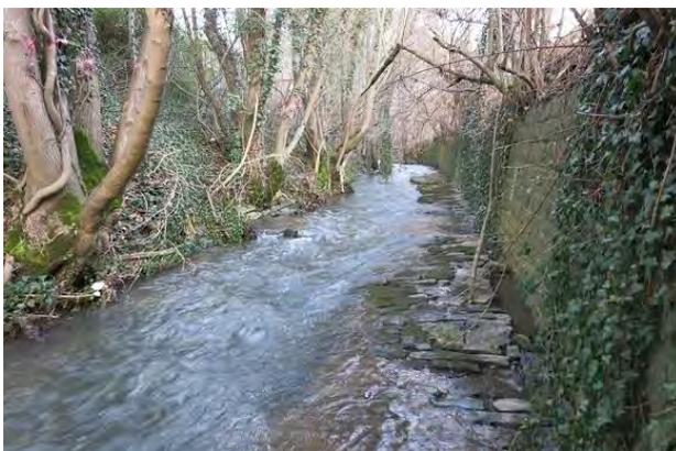
**Abbildung 67: Erosion in der Sohl-sicherung (Blick gegen Fließrichtung)**
