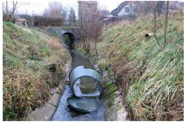
**Abbildung 27: Sohlshalen am Gewässer (Blick gegen Fließrichtung)**
