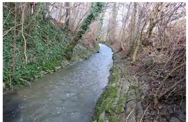
**Abbildung 68: Sicherungen aus Böschungs- und Sohlpflaster (Blick gegen Fließrichtung)**
