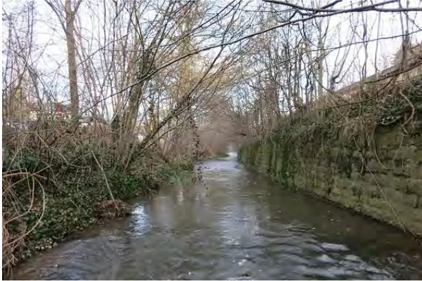
**Abbildung 65: Ufermauer als Ufersicherung zur Bundesstraße (Blick gegen Fließrichtung)**
