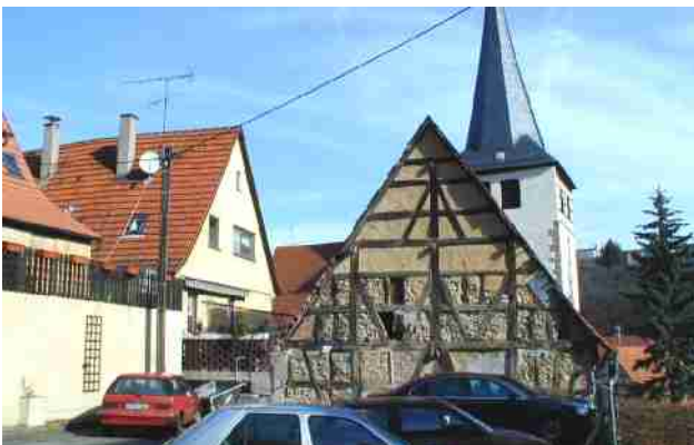
Ebenfalls unbefriedigend stellt sich die Situa- tion im Bereich der Ochsengasse 5 dar, wo nach Abriss eines Gebäudes eine Baulücke entstand, die aufgrund ihrer geringen Größe für eine Neubebauung ungeeignet ist. Eine Zeitlang galt die Fläche als Stellplatznachweis für genehmigte aber nicht umgesetzte Nut- zungen im EG des Gebäudes Ochsengasse 8. Die Fläche ist bis heute ungestaltet und wird als Stellplatz genutzt.
