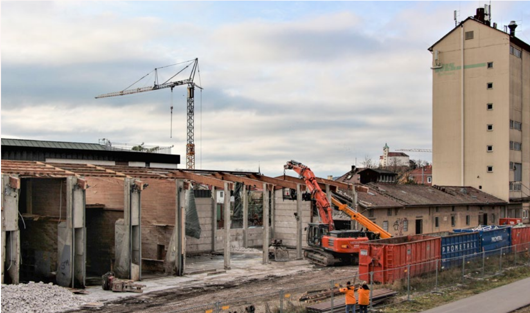
Ende 2021 wird ein Großteil des alten BayWa-Geländes abgerissen.
