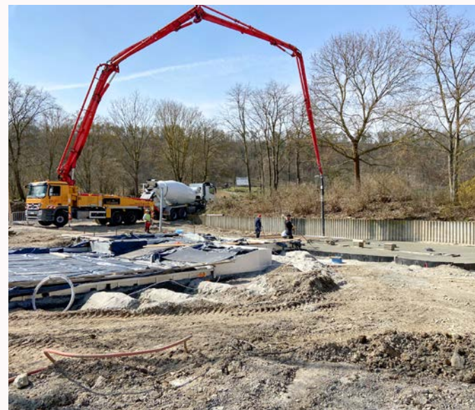
Die neuen Kinderbecken werden betoniert.
