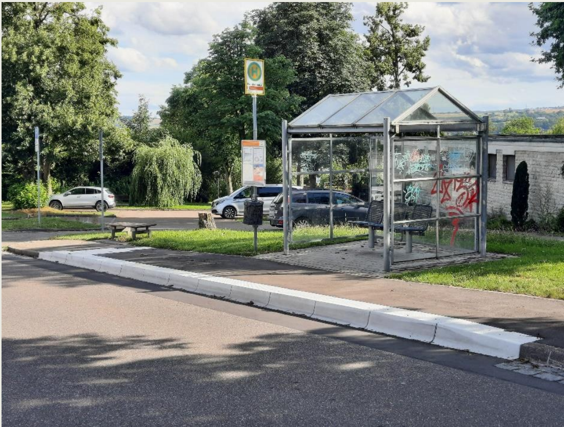
Barrierefreier Umbau von Bushaltestellen
